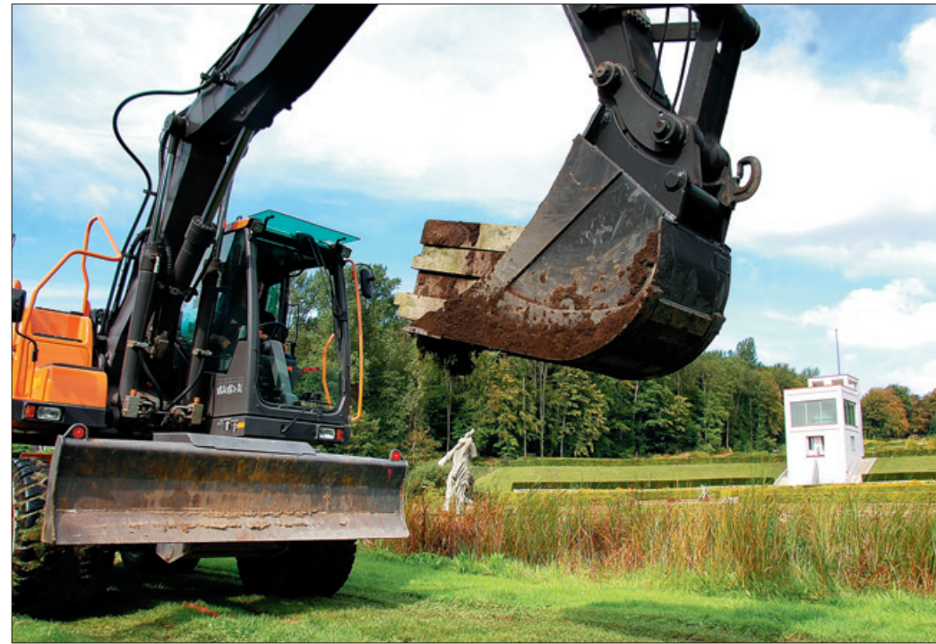
Schweres Gerät am Herkulesteich: Zunächst wird der Süddamm gesichert.
